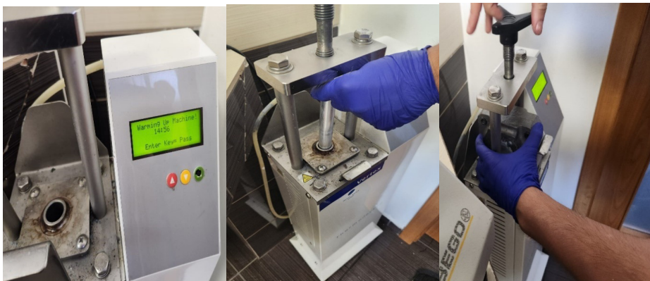
Figura 133. Injectarea unei rășini termoplastice.
